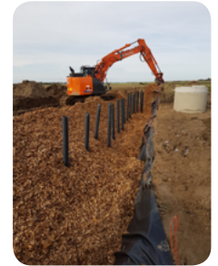
Bau Draingraben 2017
