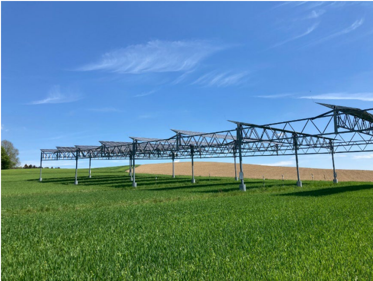
Abb. 1: Bei Dürre sogar ertragssteigernd: Hoch aufgeständerte Agri-Fotovoltaik-Anlagen schützen durch Beschattung (Foto: Universität Hohenheim / Andreas Schweiger).
