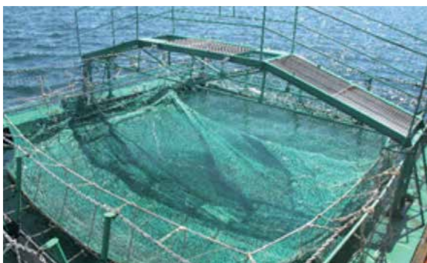
Abbildung 4: Stahlträgernetzkäfig im Fischereischutzgebiet Nienhagen
