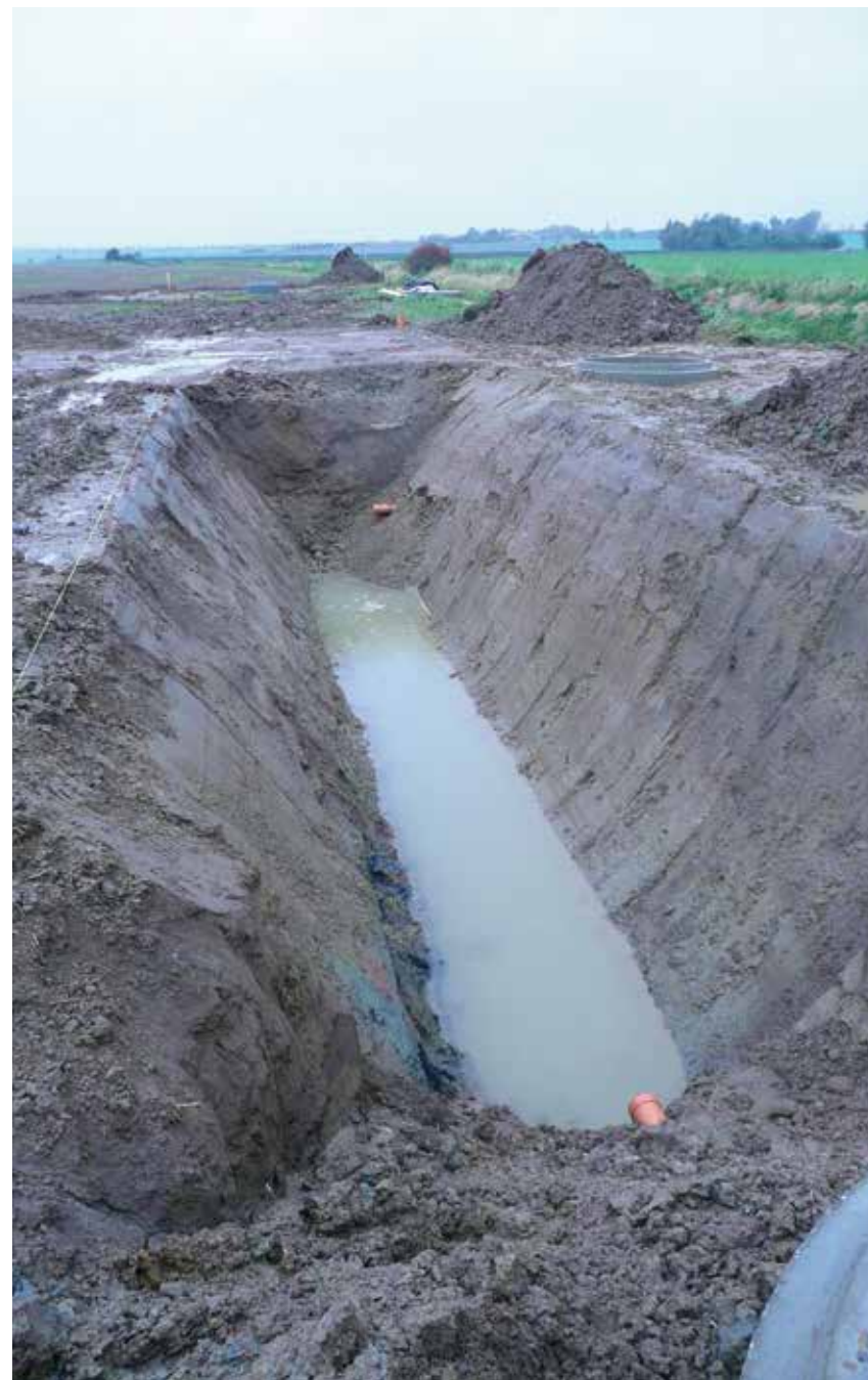
Abbildung 1: Bau des reaktiven Drängrabens
