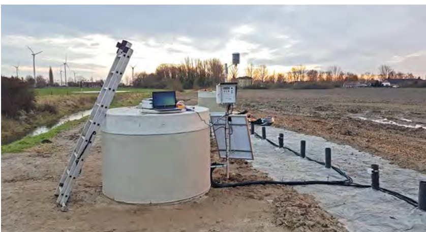
Abb. 4 Installierte Messtechnik mit Solarpanel am reaktiven Graben
