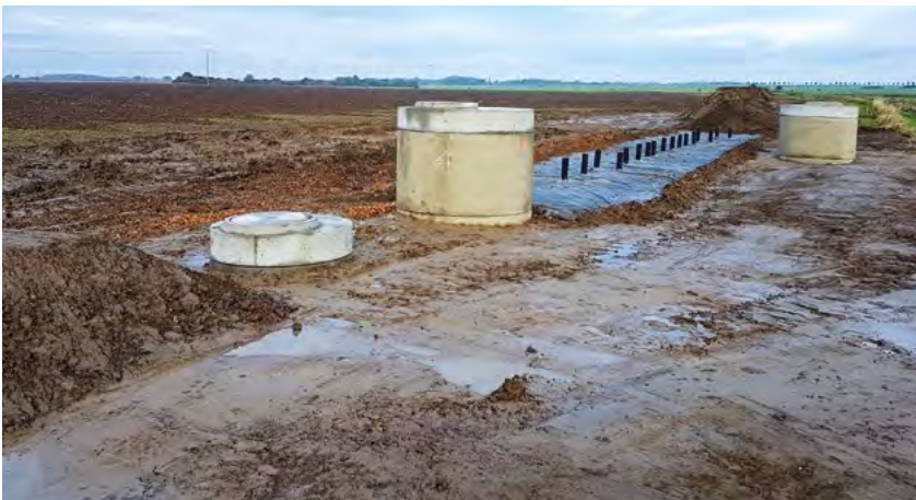
Abb. 3: Der reaktive Graben nach Fertigstellung der Baumaßnahmen
