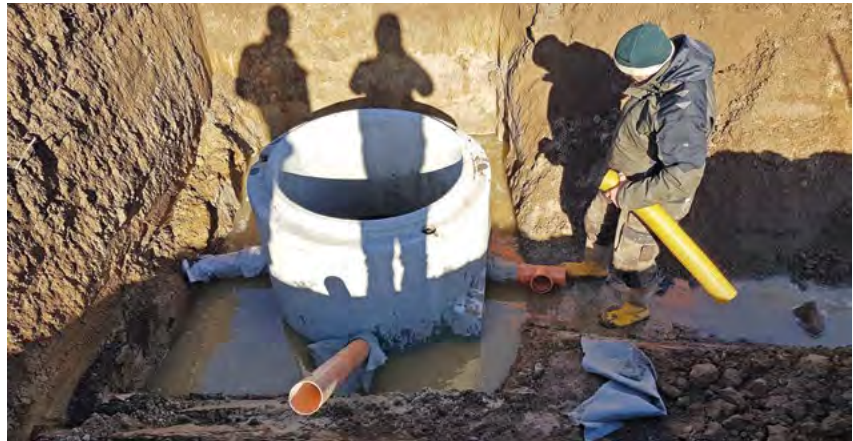
Abb. 1.: Anschluss der Revisionsschächte
