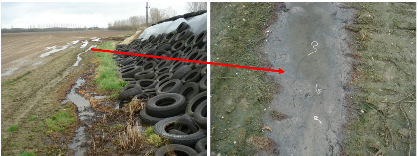
Abbildung 2: Unsachgemäße Lagerung von Gärfutter
